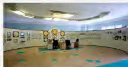
Panel de control de la planta nuclear Obninsk. Foto: Ilya Varlamov
